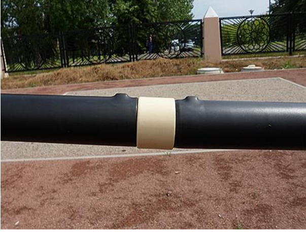
4.16: Düz segmentlerin montajı
