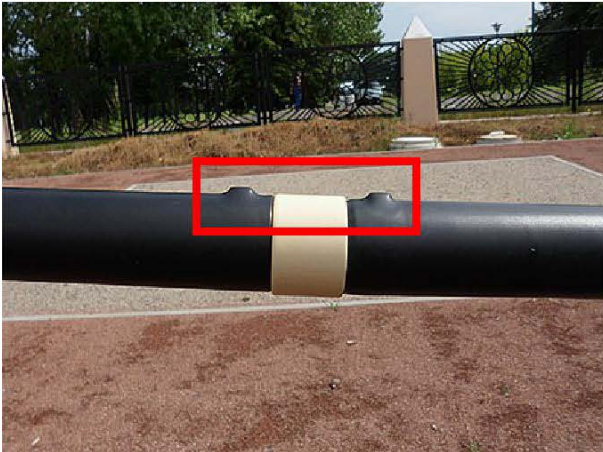
Ilustración 4.16: Montaje de los segmentos rectos
